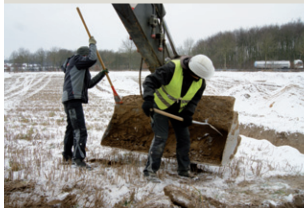
Wenn die Erde in der Baggerschaufel festfriert, steht die Grabung still.
